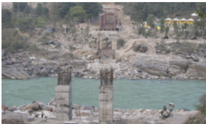
De brug in aanbouw over de Ganges
